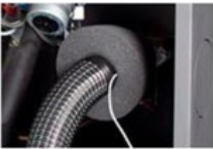
Abb. 64: Anschluss an das Abgasrohr der Feuerstätte
