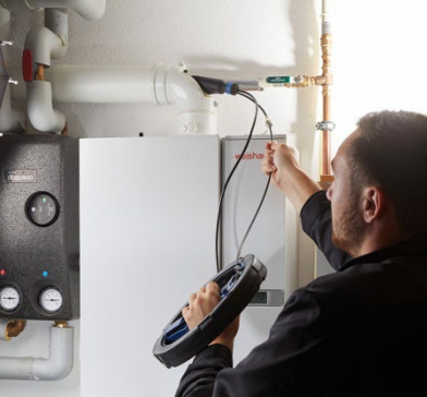
Abb. 13: Positionieren der oberen Abdichtblase mit Teleskopset und Haspel.
